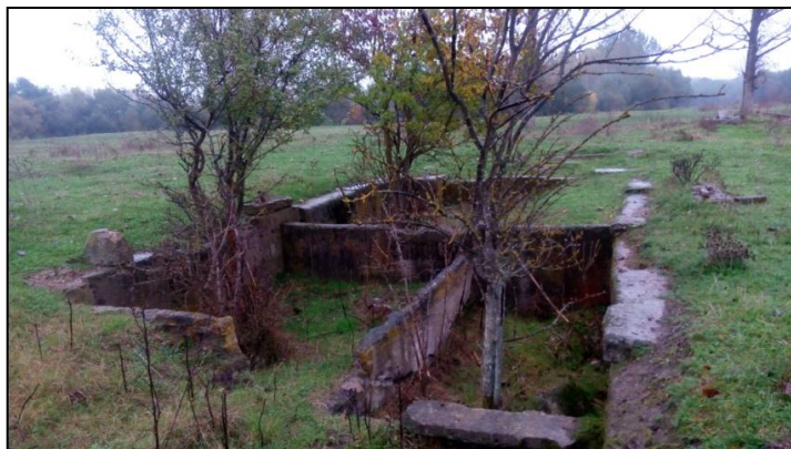
Фиг.38. Част от терена на цигларната фабрика
